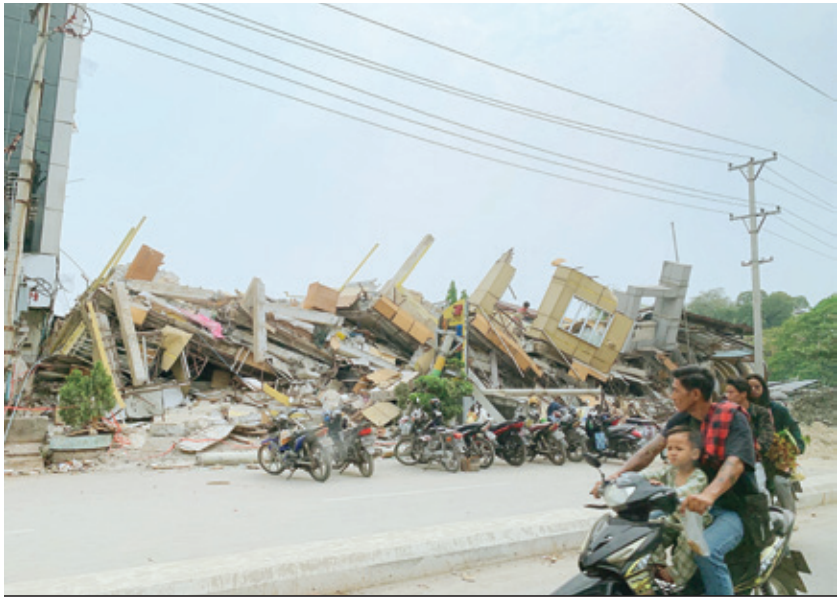
Warga Kota Mandalay melintasi bangunan yang roboh di jalan Mahar Aung Myay Township. | Foto: Theophilus Yanuarto
