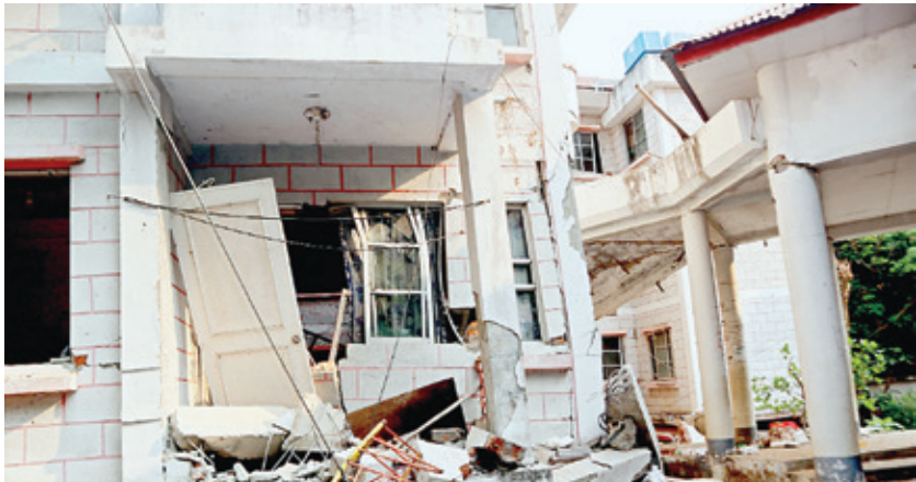
Kerusakan bangunan di perumahan pegawai negeri sipil di Thukha Theiddhi Ward, Nay Pyi Taw.
