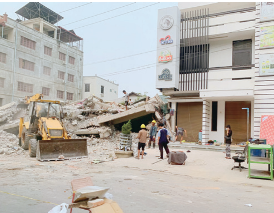
Pembersihan puing bangunan roboh dengan alat berat jelang sepekan pascagempa M7,7 yang mengguncang Kota Mandalay. | Foto: Theophilus Yanuarto
